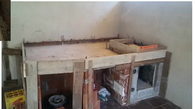
Coffrage dalle isolante - N
