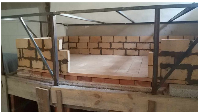
Murs et structure acier
