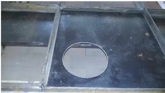
Orifice du tuyau de cheminée - N
