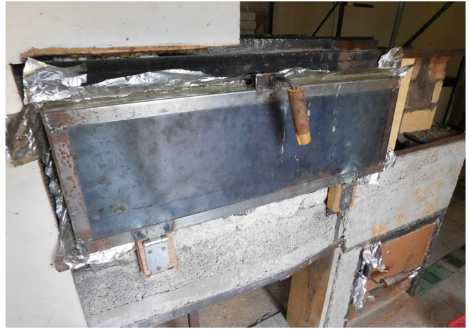
Portes avec enduit d'étanchéité - E
