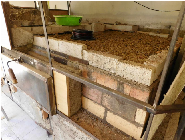
Dalle à inertie du plafond - E
