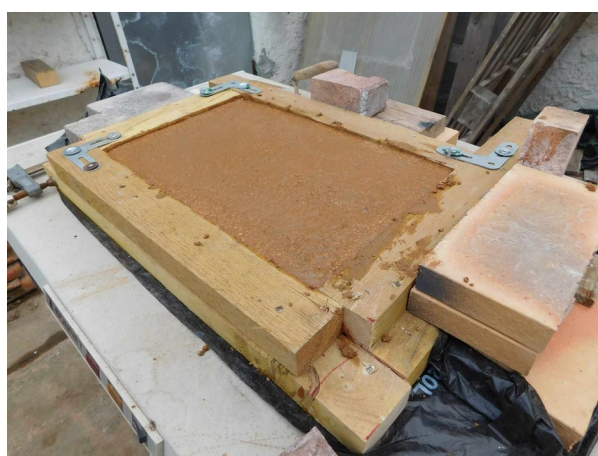
Coffrage de la porte du foyer - E
