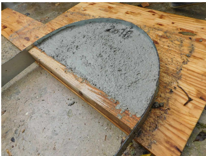
Coulage du fronton - E
