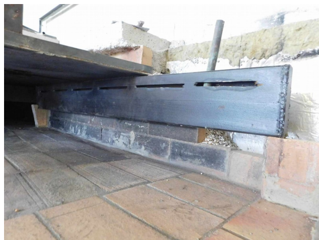
Pose évaporateur - E
