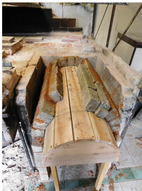
Montage de la voûte - E
