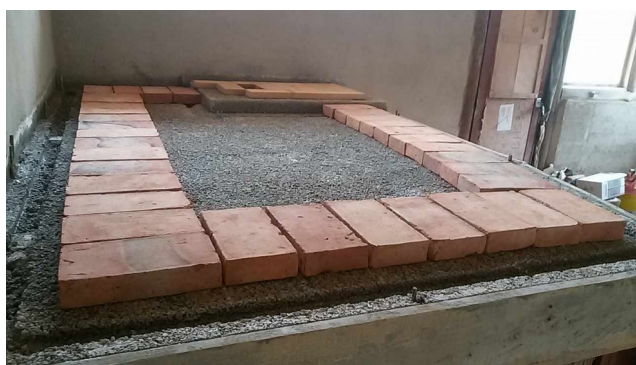
Ceinture en briques - N
