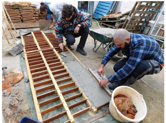
Coulage des briques isolantes - E
