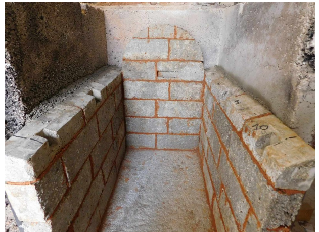
Murs support de voûte - E
