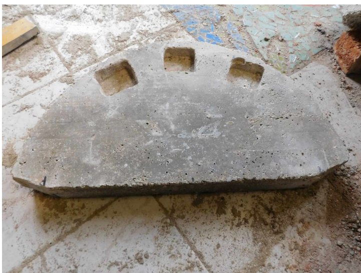
Encoches dans le fronton - E
