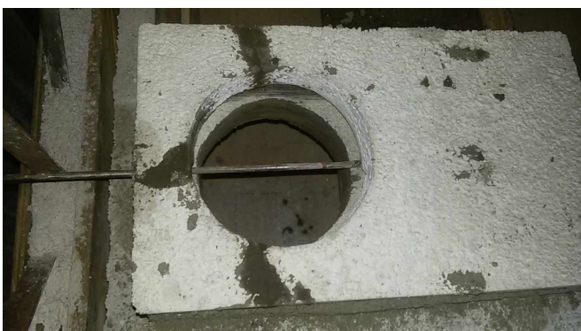
Dalles isolantes du clapet - N
