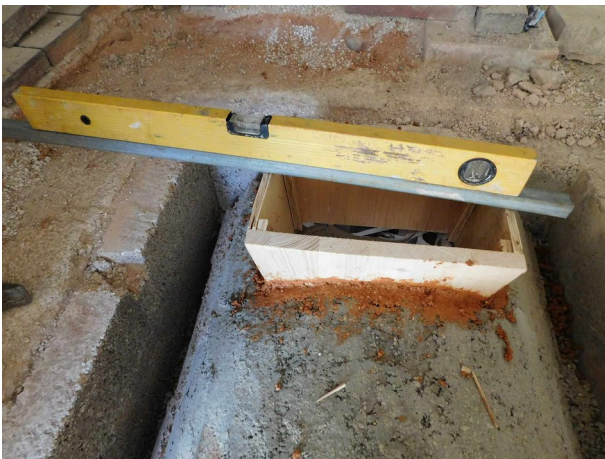
Coffrage gueulard - N
