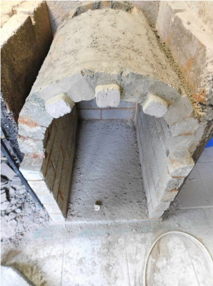
Foyer : pose du fronton - E
