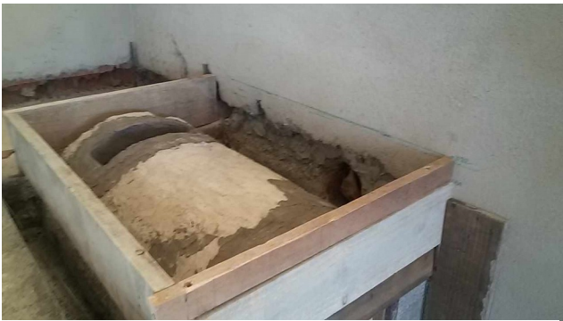
Coffrage dalle isolante - N
