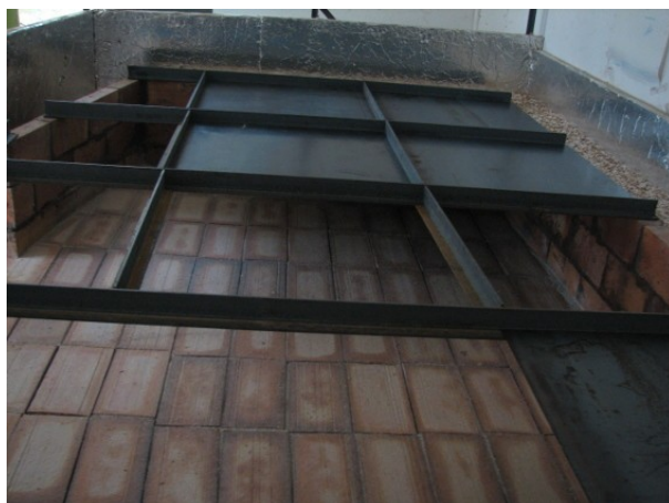
Structure de plafond - E
